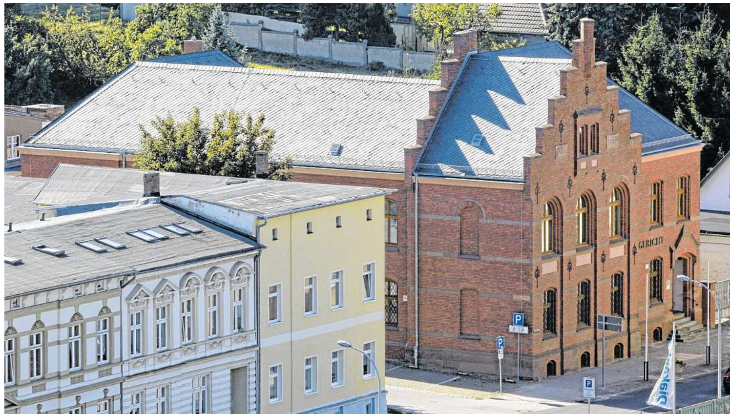
Im früheren Gerichtsgebäude sollen nach dem Willen der AWO u.a. die Geschäftsstelle und zwei Hortgruppen einziehen. FOTO: TILO WALLRODT
