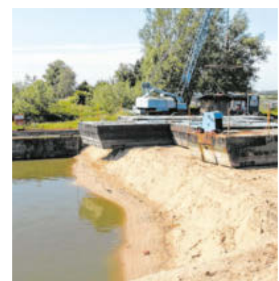
Das Hafenbecken wird bereits mit Sand zugeschüttet.
