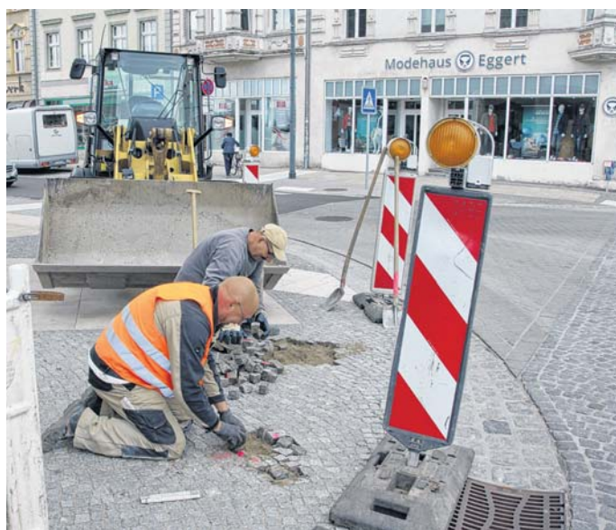
Für die vier Granitkugeln wurden gestern die Fundamente gesetzt – die Kugeln werden in der nächsten Woche montiert.
